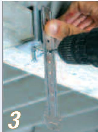
Pose et réglage de la hauteur de la patte de fixation. (repère b).
