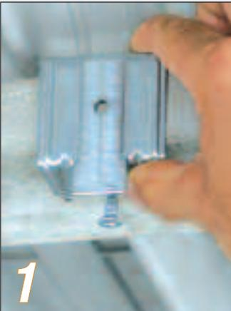
Pose de la Suspente Leader Universelle sur le talon de la poutrelle (repère a).
