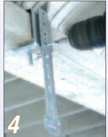
Fixation (optionnelle) d'une 2ème vis autoperceuse pour un bon maintien latéral de la suspenste.
