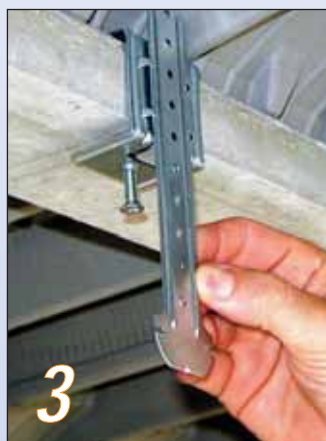
3 Pose et réglage de la hauteur de la patte de fixation (repère b).
