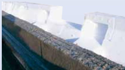
Un emboîtement précis garantit la continuité de l'isolation.
