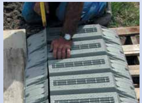
Découpe facile à la scie manuelle ou électrique.
