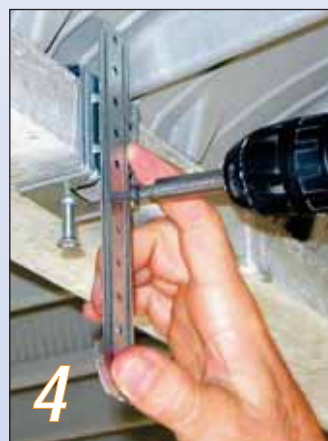
4 Fixation à l'aide d'une vis de 10mm auto-perceuse dans la rainure d'amorçage (repère c).
