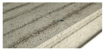
Le DAK affleure la face supérieure de la Dalle Alvéolée pour une fiabilité et une sécurité chantier optimale.
