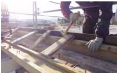
aux coffrages de rives compliqués et fatigants.
