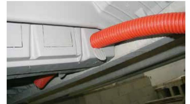
Pour le passage de réseau en sous-face du Plancher EMX, utiliser les Tympan (tympan pré-perçés).
