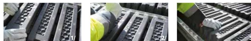
Pour effectuer la mise en œuvre des entrevous EMX, l'opérateur peut être situé au-dessous (plancher d'étage) ou au-dessus (plancher VS) du plancher, ou encore en extrémité de la travée.
