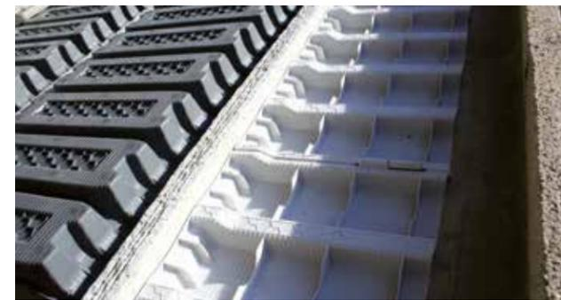
Pour la réalisation des travées démodulées en rive, prendre les mêmes dispositions que précédemment pour les découpes et s'assurer que l'appui sur le mur (c'est-à-dire le côté découpé du Modulo) soit de 5 cm minimum. Le côté non découpé est en appui sur la poutrelle. Une disposition doit être adoptée afin d'assurer le maintien provisoire de l'élément en place (exemple : fixation par pointage sur la maçonnerie).
