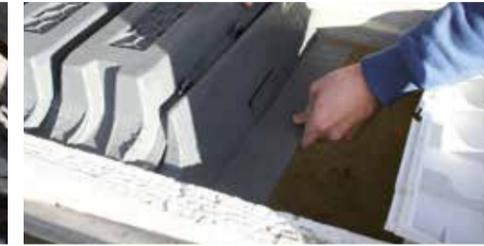
Connecter le côté non découpé de l'EMX Modulo à la face arrière du tympan (zone d'accroche prévue). A noter que pour assurer une bonne étanchéité au coulage, l'EMX Modulo découpé doit venir en appui sur 5 cm sur l'arase du mur.
