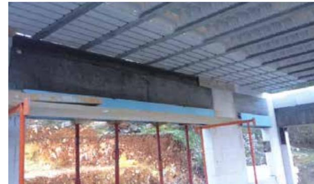
Pour la réalisation des zones négatives (ex. : contre-balance de balcon), la jonction entre l'EMX et l'EMX Modulo se fait de la même façon que pour les zones biaisées. Dans ce cas, l'EMX Modulo aide au bon positionnement des poutrelles (il détermine l'entraxe).
