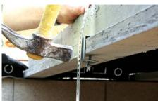
Accrocher la patte à la hauteur voulue grâce aux ergots de fixation prévus à cet effet sur la Suspente VS. Si besoin, pour éviter des mouvements verticaux. enfoncer les ergots à l'aide d'un marteau.
